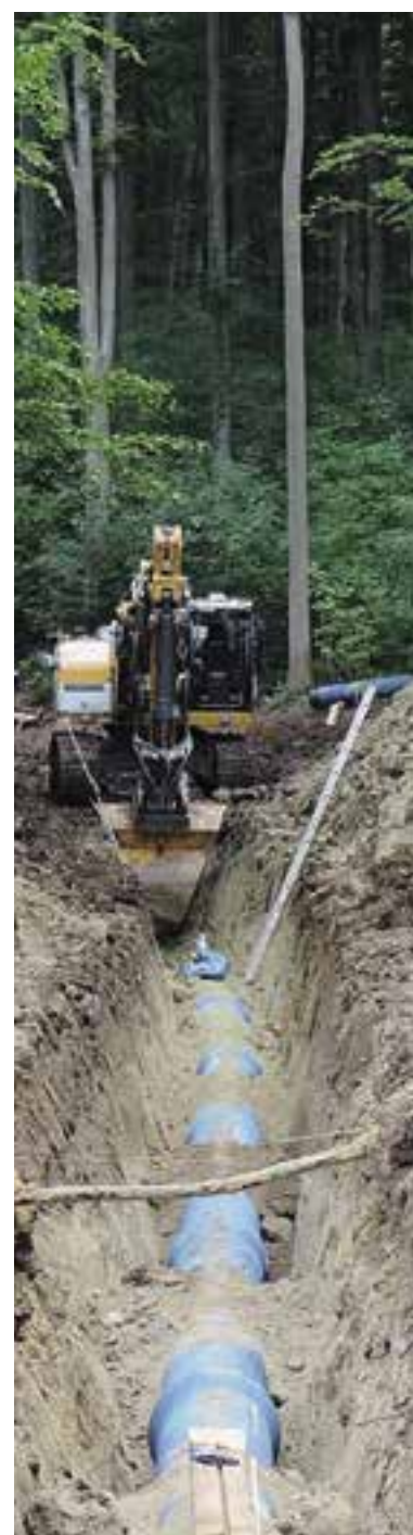
Naturschonende Verlegung der Rohrleitung im Wald
